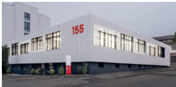
Assainissement à La Chaux-de-Fonds réalisé par Metri. DR
