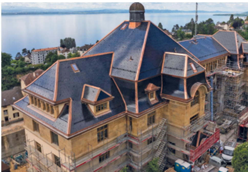
Collège des Parcs Neuchâtel, un toit extrêmement complexe. DR
