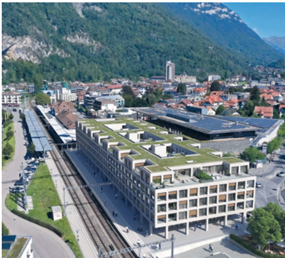
Le projet d'Interlaken prévoyait un nouveau bâtiment comprenant 58 appartements et un hôtel. DR
